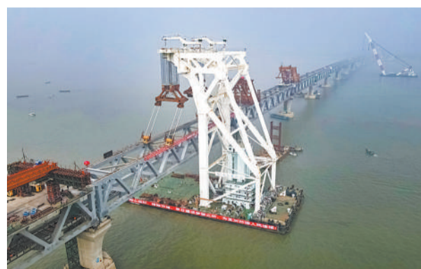
图为位于孟加拉国首都达卡西南约40公里处的帕德玛大桥项目现场,万吨级中心架梁起重船“天一号”将最后一跨钢架梁架到指定桥墩上。(新华社发)
