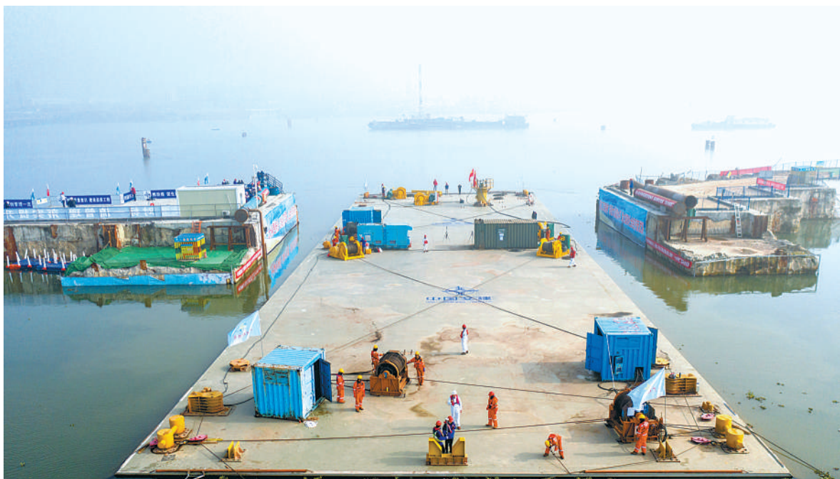
12月12日,在湖北省襄阳市,襄阳东西轴线鱼梁洲隧道首节沉管开始浮运安装。据了解,襄阳东西轴线鱼梁洲段项目是连接东津新区与樊城区的一条快速通道,全长5.4公里,其中下穿汉江的沉管隧道总长1.01公里,是目前国内整体建设规模最大的内河沉管隧道。
