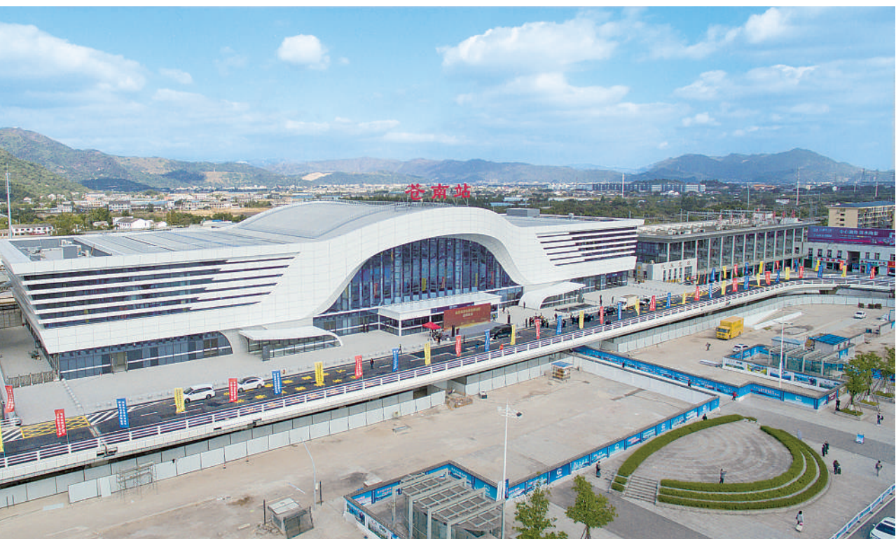
12月2日,浙江温州,由中铁四局建筑公司承建的杭深铁路苍南高铁站正式启用。据了解,该项目总投资6.4亿元,改扩建后,建筑面积由原来的4200平方米增加到26993平方米,站房可同时承载乘客2600人,是全国最大的县级高铁站。
