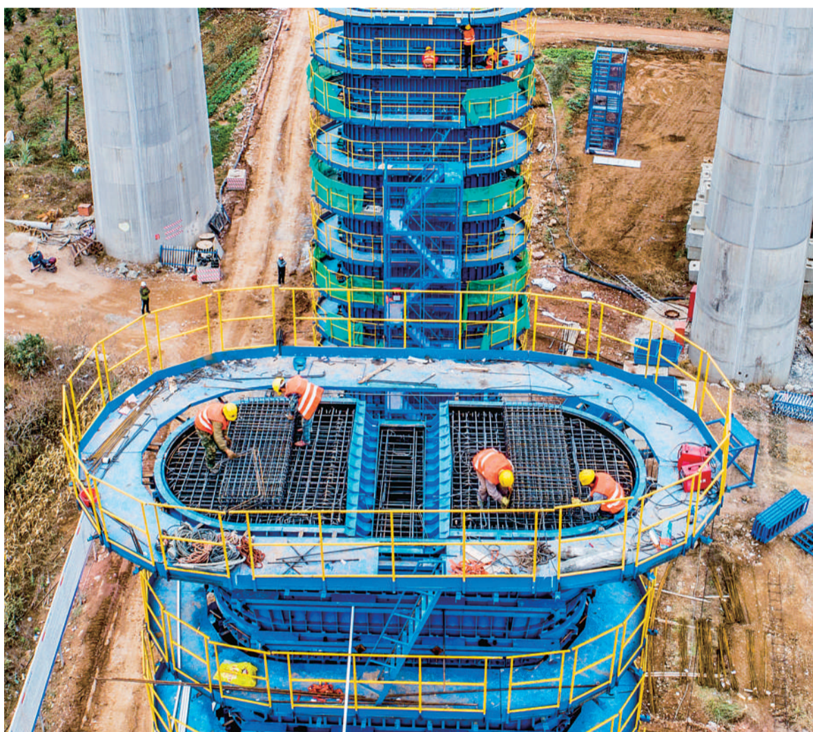
杭温高铁建设正酣
