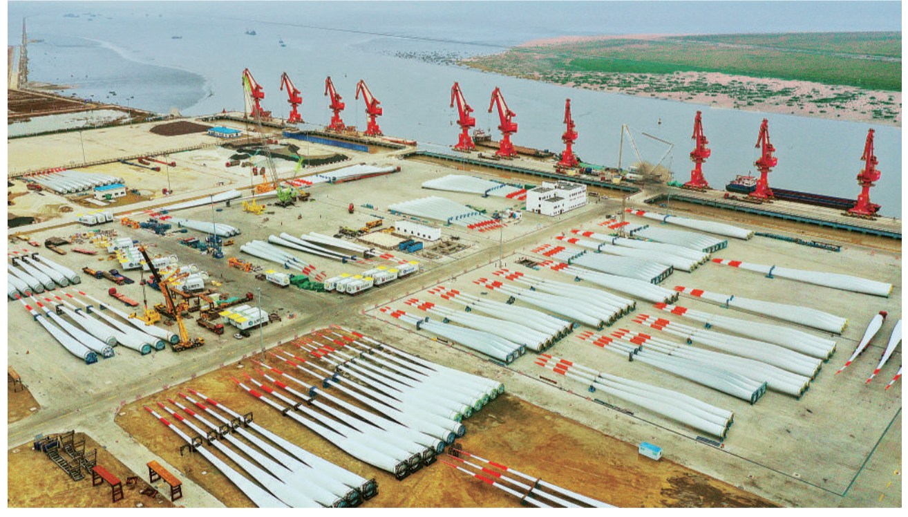
11月21日，江苏省盐城市射阳港大批风电装备等待外运。近年来，射阳县加快建设射阳港，打造行业领先的风电装备产业母港。目前已建成南北双导堤、3.5万吨级通用码头，风电大件码头和省级示范物流园已获批建设。今年可完成风电设备装卸400台套以上。 肖勇摄(中经视觉)
