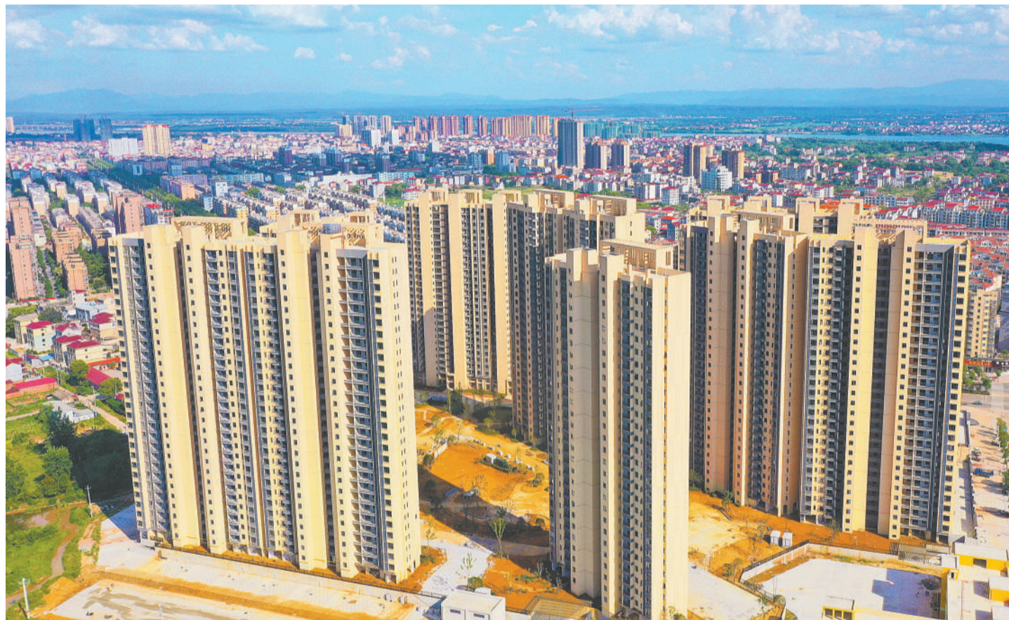
近日，江西省吉安市泰和县城一安置房小区楼房主体工程建成完工，进入小区地面平整、绿化美化等附属设施施工阶段。
