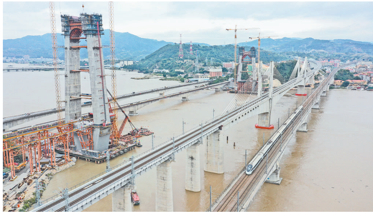
11月14日,新建福厦铁路乌龙江大桥首根钢箱梁架设现场(无人机照片)。当日,由中国中铁大桥局承建的大跨度四线铁路高低塔双索面混合梁斜拉桥——新建福厦铁路乌龙江大桥首根钢箱梁成功架设,标志着主跨达432米的新建福厦铁路乌龙江大桥全面进入上部结构施工。新建福厦铁路乌龙江大桥是新建福厦铁路全线关键控制性工程,大桥全长739.9米。
