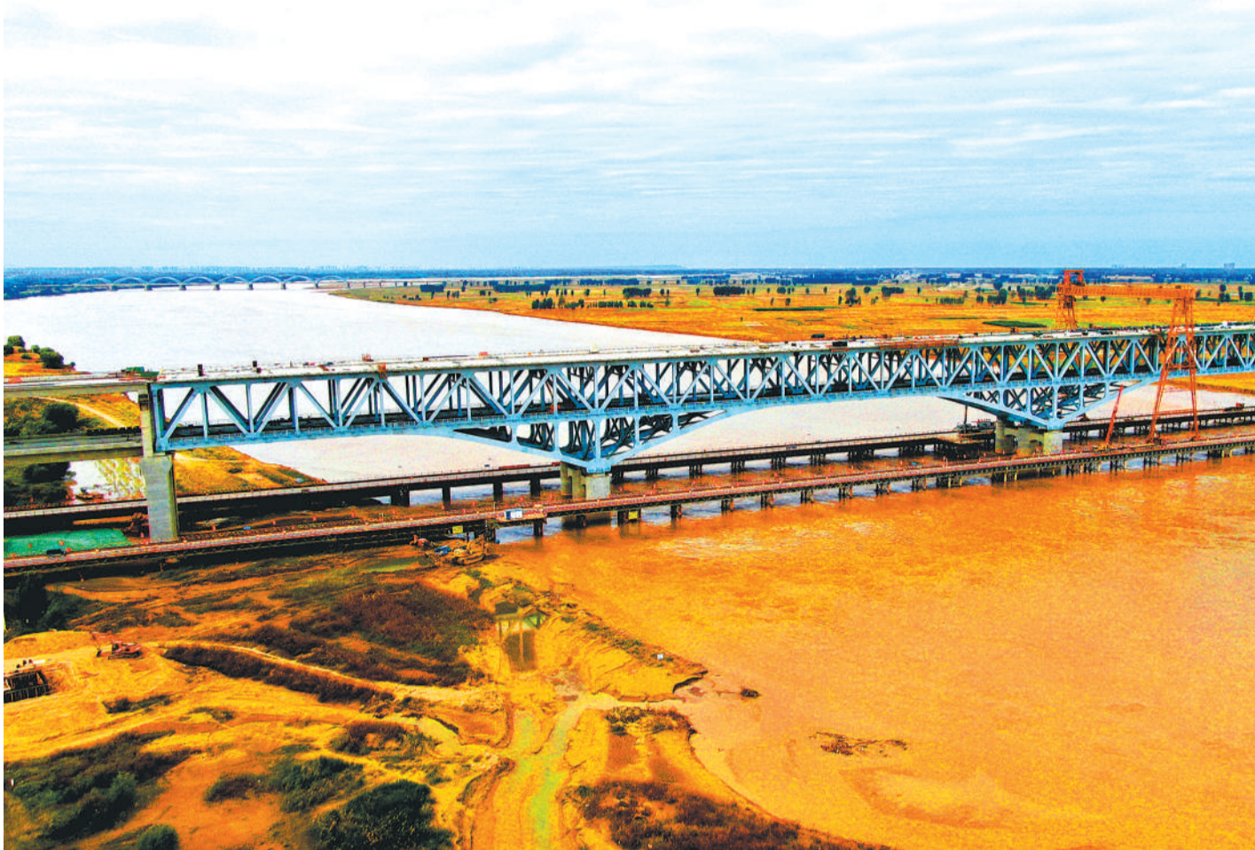
施工中的郑济铁路郑州黄河特大桥。
