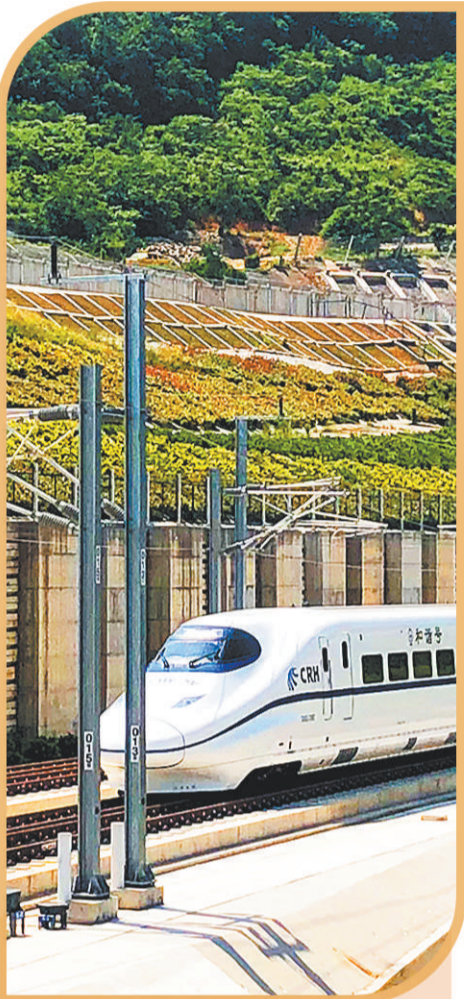
上图 2020年,商合杭高铁全线贯通。图为和谐号列车经过大力寺隧道。陆应军摄(中经视觉)
