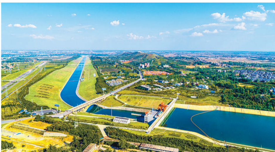
俯瞰南水北调中线工程渠首。
