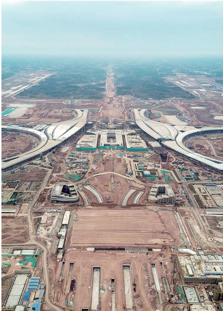
建设中的天府国际机场。
