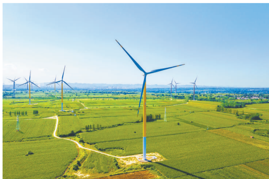
这是河南省安阳市汤阴风电场内的风机。
