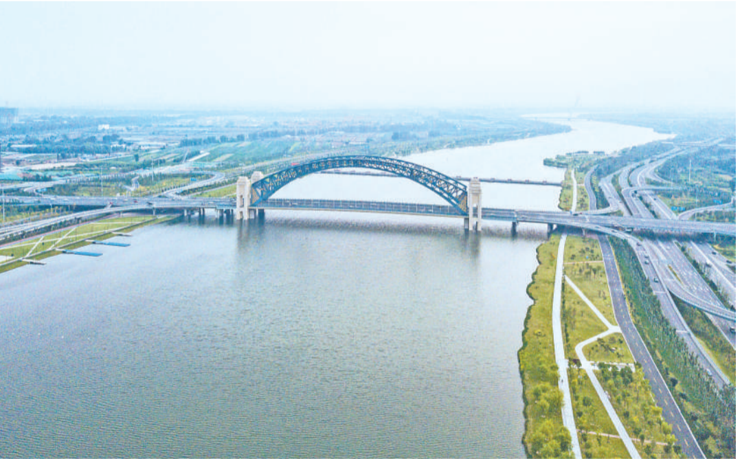
9月21日在山西太原拍摄的汾河三期治理工程晋阳桥段（无人机照片）。
