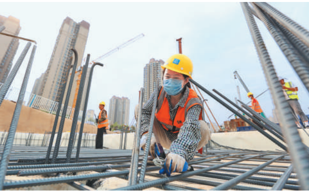
10月8日，中建二局第二建筑工程有限公司西安项目工地上，工人正在绑扎钢筋，为浇筑做准备。为了确保在年底完成主体结构，工人们在长假期间坚守岗位，加紧开工建设。 贾学超摄（中经视觉）
