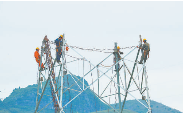
10月8日，湖南省永州市新田县永州砾城—塘罗（路口）110kv线路工程施工现场，电力施工人员正在开展高空施工作业。长假期间，该项目电力工程施工队队员们提前返岗，抓紧施工，确保工程如期完成。 刘贵雄摄（中经视觉）
