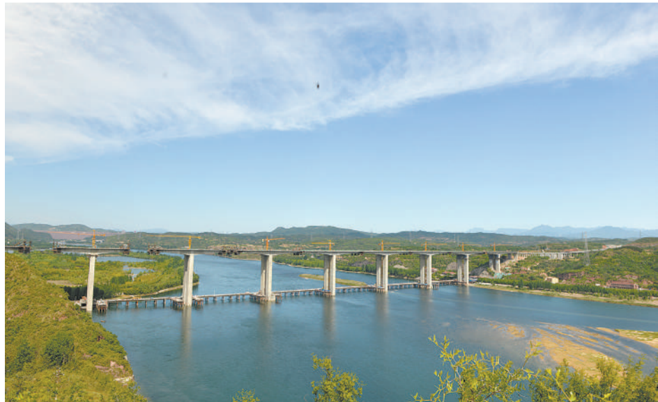
建设中的济洛西高速黄河大桥。
