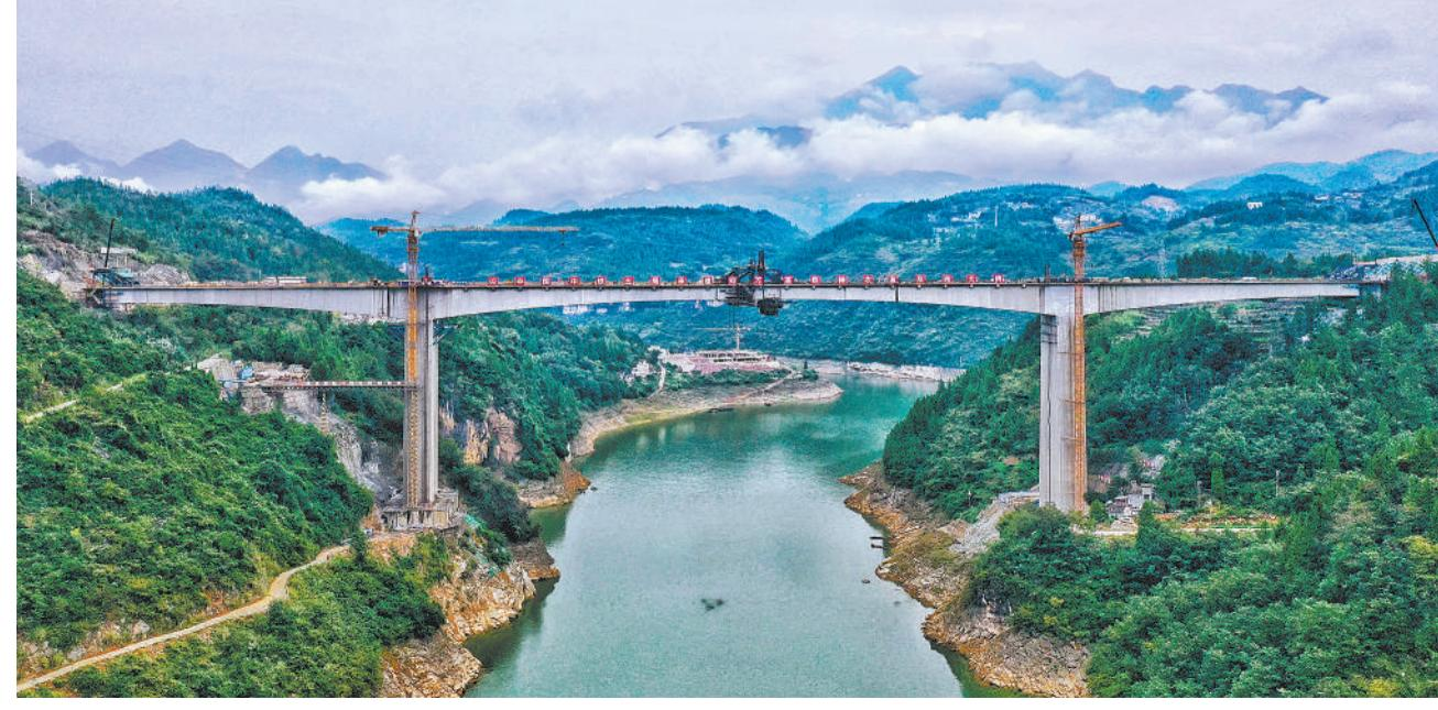
9月29日，郑万高铁控制性工程神农溪双线大桥雄姿。由中铁五局施工的郑（州）万（州）高铁建设项目中跨度最大、施工难度最高的湖北巴东段神农溪双线大桥于9月28日成功合龙。据悉，郑万高铁湖北段全长286公里，设计时速350公里，总投资446亿元，预计2022年建成通车。
