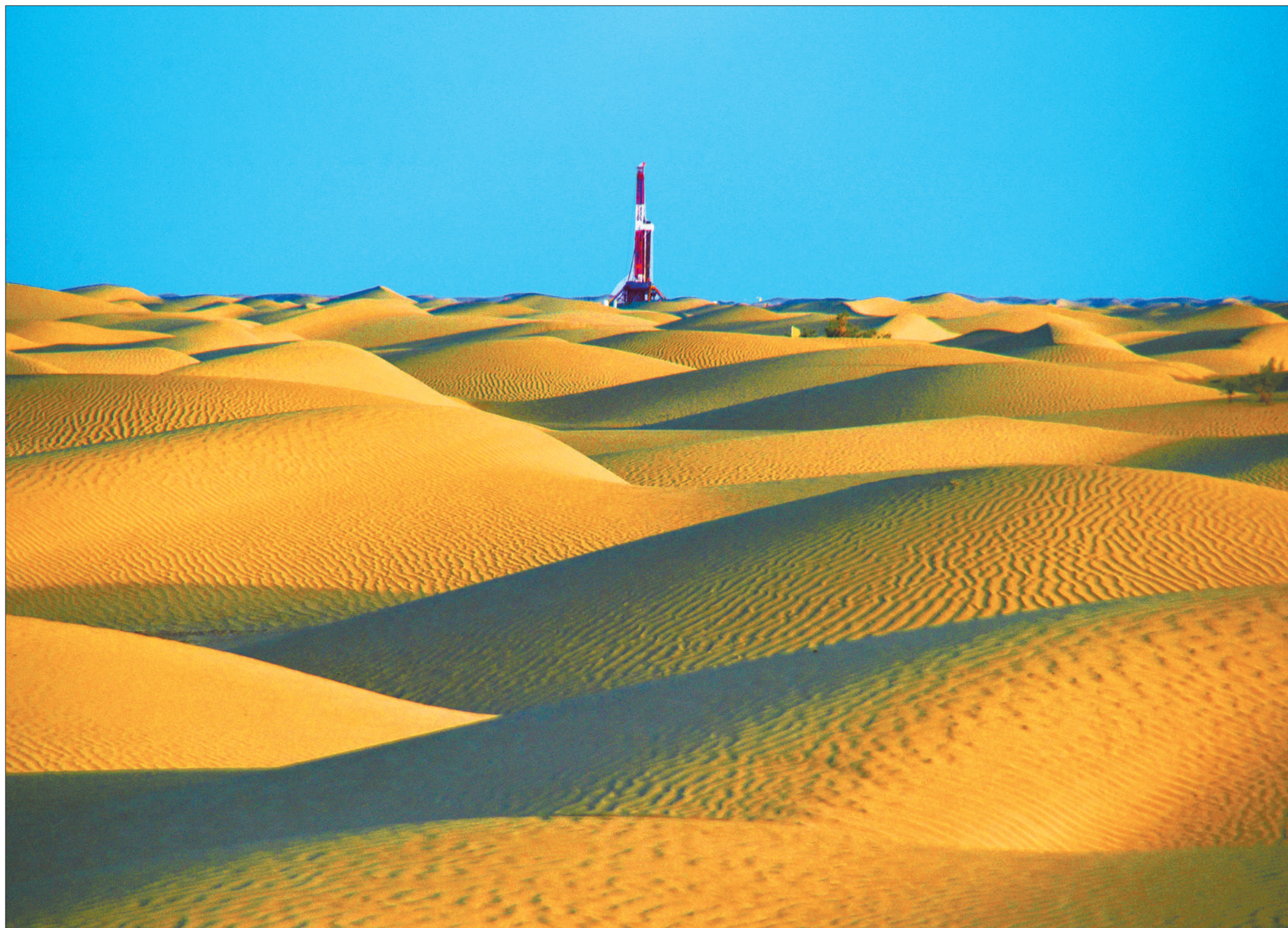
▲新疆塔克拉玛干沙漠里的中国石化西北油田分公司顺北油气田，石油工人在浩瀚的沙漠开采作业。该油气田自2016年开发以来，以日产原油2600吨、天然气80万立方米的速度，迈向年产100万吨目标，实现了产量三年三级跳。 范明摄
