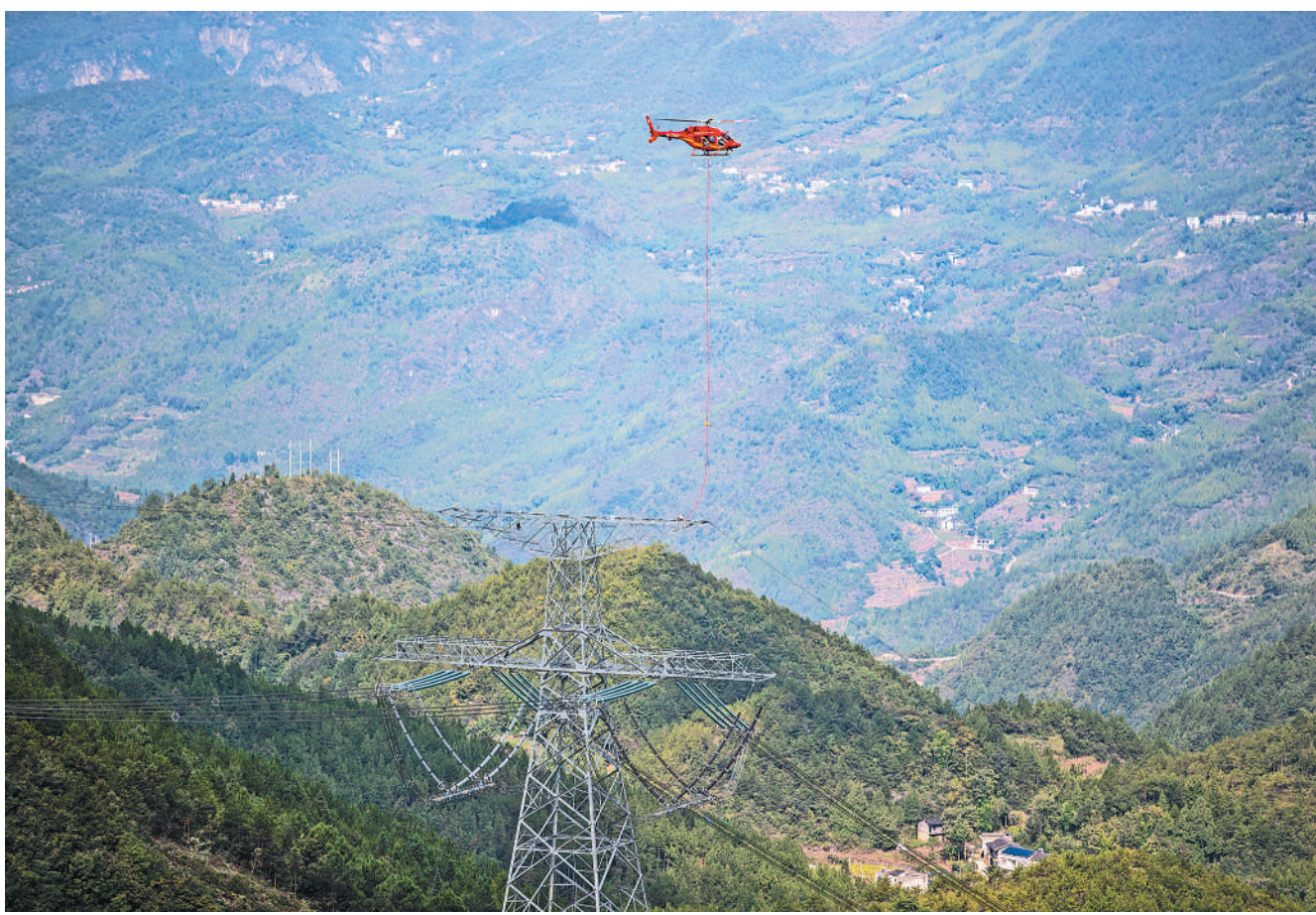
国家电网完成首次山地特高压线路直升机带电检修
