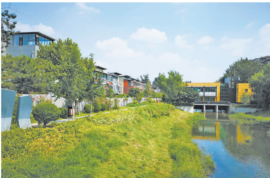
改造后的北京市大兴区新风河李营闸段景色。
