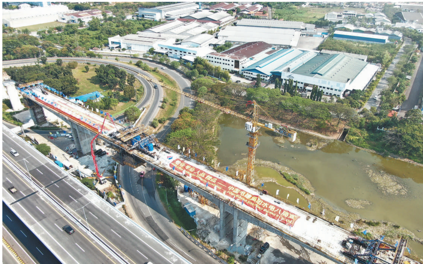
图为雅万高铁1号梁场施工现场。
