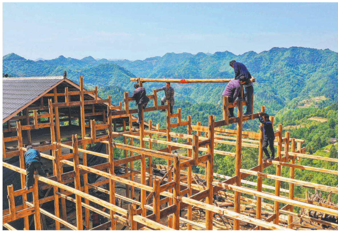
左图 日前,贵州省铜仁市玉屏侗族自治县新店镇大湾村村民在吊脚楼上主梁。 胡攀学摄(中经视觉)
