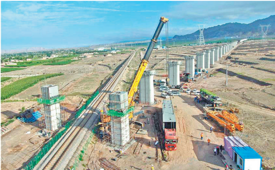
近日,位于甘肃白银市平川区的中(卫)兰(州)客专二标段水泉特大桥68#墩上跨王家山煤矿专用线门式墩钢梁顺利吊装到位。兰州铁路局和中铁大桥局对施工方案可行性进行了充分论证,确保吊装任务安全、精准、高标准完成。
