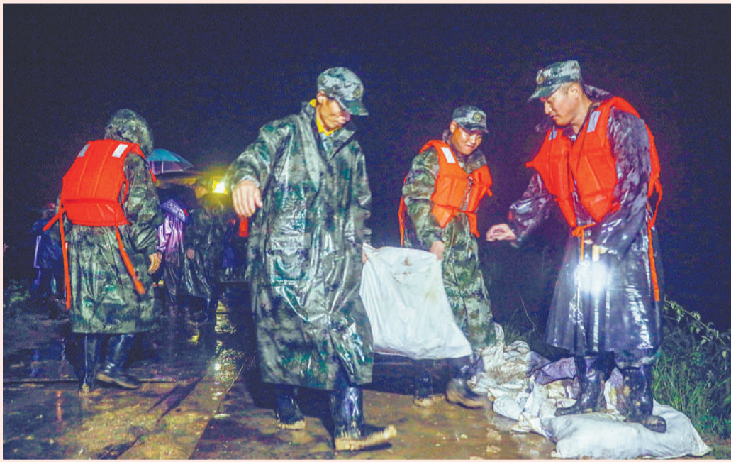
7月18日,安徽省庐江县石头镇白新圩大堤上,来自庐江县各镇支援的民兵抢险应急突击队正在冒雨连夜填沙包筑堤。
