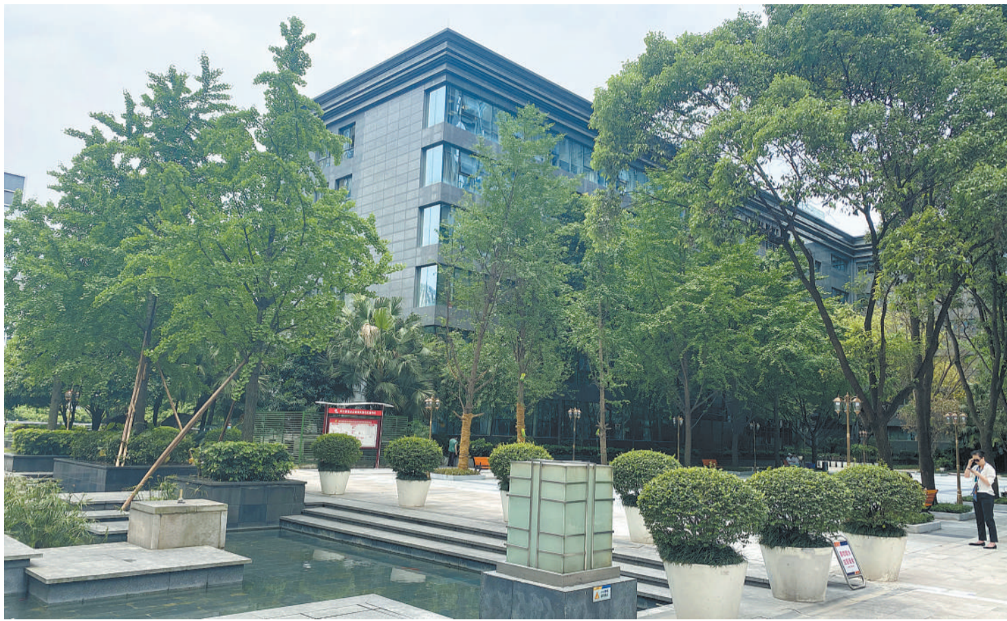
图为重庆两江新区新科国际海绵城市广场。该广场通过透水铺装、下凹式绿地等技术打造了一个微型海绵体。（资料图片）
