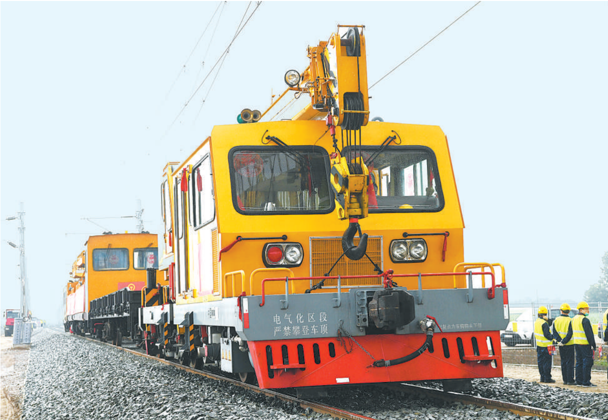
塞尔维亚总统武契奇5月30日在视察匈塞铁路建设工地时说,匈塞铁路项目对塞尔维亚至关重要,将提高沿线民众生活水平,提振当地经济发展。匈塞铁路改造项目是中国—中东欧国家合作的标志性项目,连接布达佩斯与贝尔格莱德,全长350公里,其中贝尔格莱德至旧帕佐瓦段长34.5公里。图为在塞尔维亚旧帕佐瓦的匈塞铁路建设工地施工现场。
