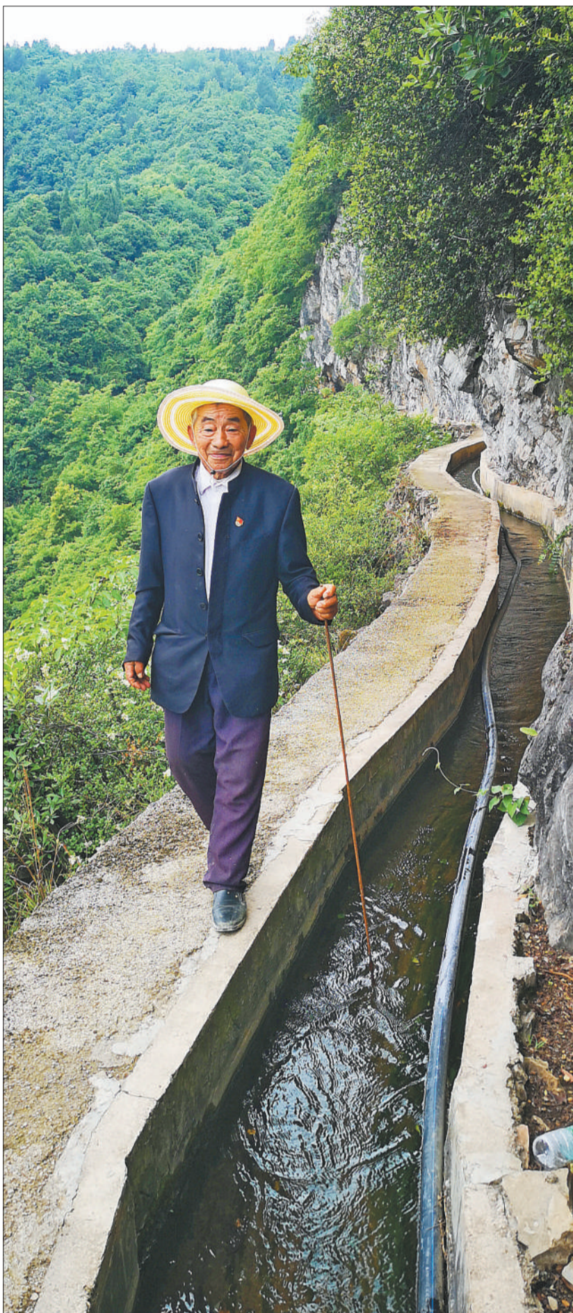
▲时代楷模、全国脱贫攻坚奋进奖获得者、贵州省遵义市平正乡团结村86岁的村党总支名誉书记黄大发上山巡渠。当年，黄大发带领村民靠着锄头、钢钎、铁锤和双手，用36年的时间在绝壁上凿出一条长9400米的“生命渠”，引来山间活水。
