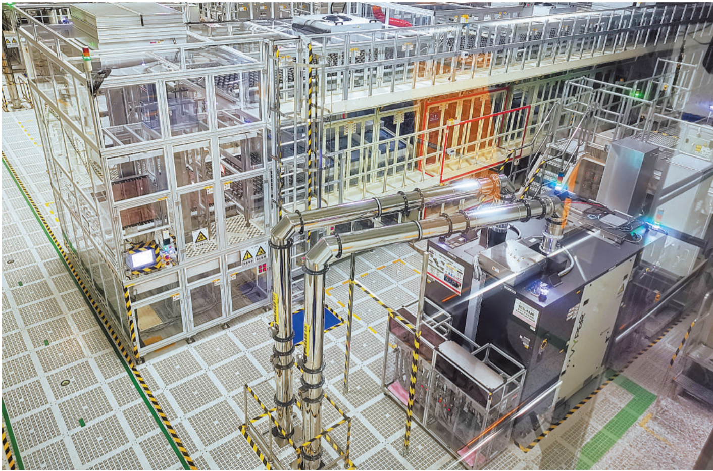
全自动化的TCL武汉华星光电T3项目生产线正在满负荷生产。
