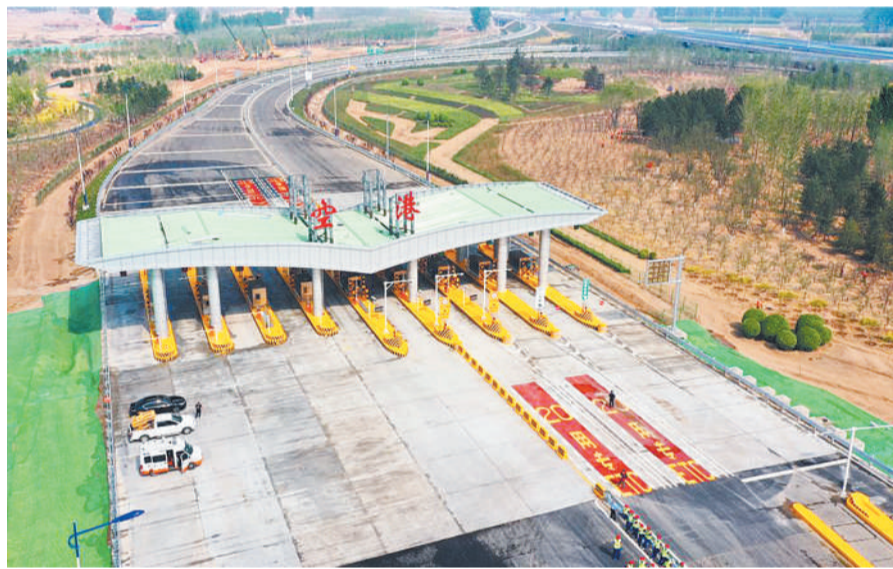
4月30日,北京大兴国际机场北线高速公路河北廊坊段建成通车。廊坊段高速全长9.971公里,总投资42.8亿元,设计时速120公里。郭京全摄(中经视觉)
