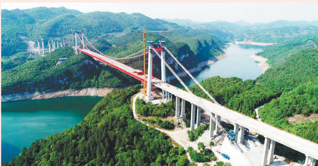
上图 4月29日,随着最后一根冲钉固定完成,贵州遵余高速公路飞龙湖乌江大桥的49片钢梁节段全部吊装完毕,成功实现钢梁合龙。由于大桥紧邻乌江构皮滩水电站水库,环保要求高,承建的中铁大桥局集团公司采用了植被混凝土生态防护技术,较好解决了岩质边坡防护与快速绿化问题。 本报记者 王新伟 通讯员 朱道权摄影报道
