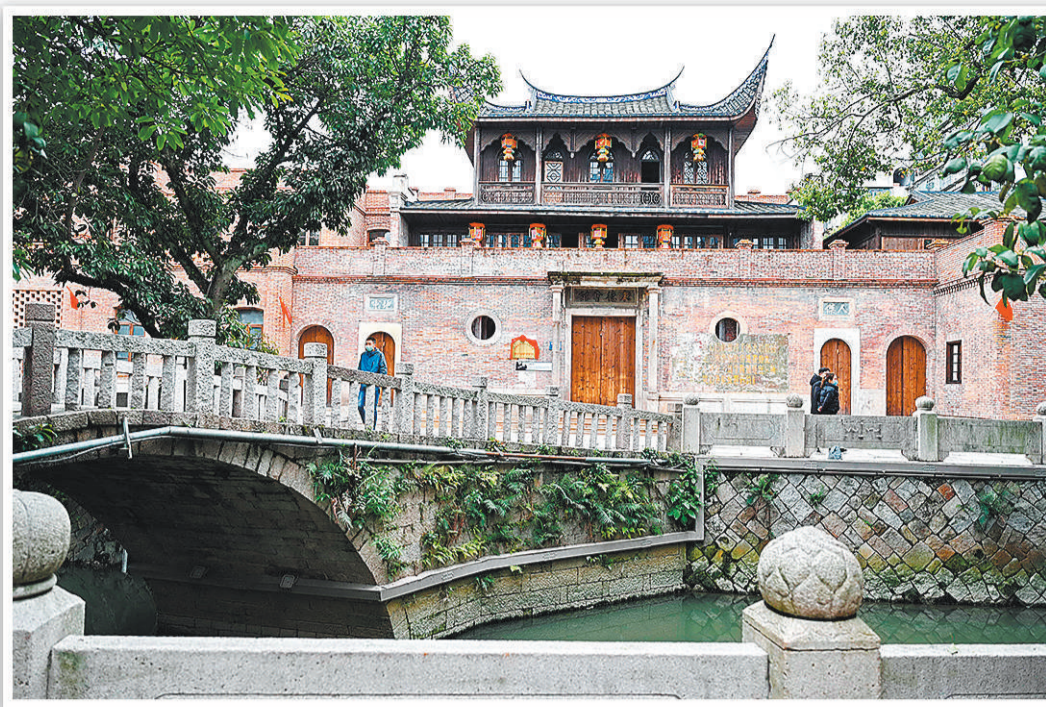
福建福州市一座中西文化相融合的近现代传统建筑——永德会馆。(新华社发)
