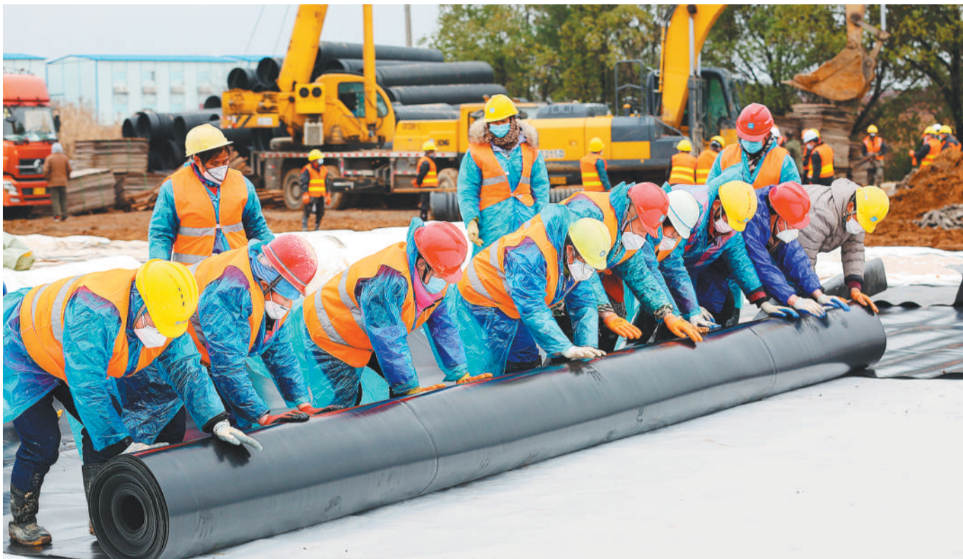
中建三局火神山医院建设者在施工现场铺设“两布一膜”防护层。
