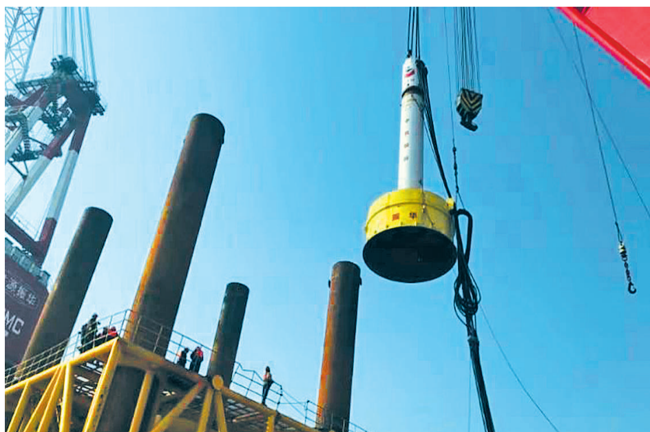
图为我国首套具有完全自主知识产权的液压打桩锤。
