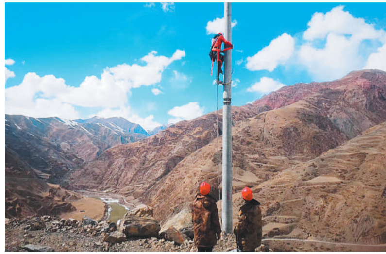
国家电网宁波供电公司援藏人员正在西藏那曲比如县扎拉乡电杆上安装横担。杜亮亮摄(中经视觉)
