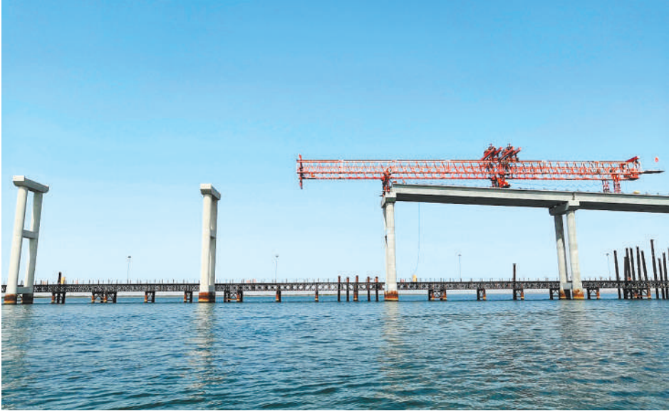
方久尼大桥架桥现场一瞥。
