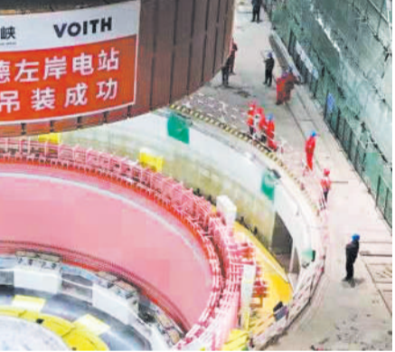
图为乌东德左岸地下电站5号机组转子吊装成功。(资料图片)
