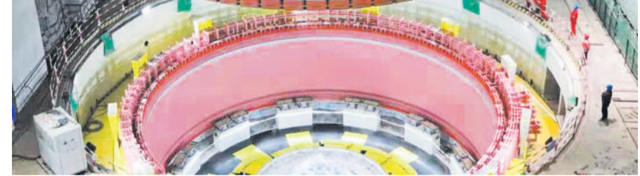
图为乌东德左岸地下电站5号机组转子吊装成功。(资料图片)
