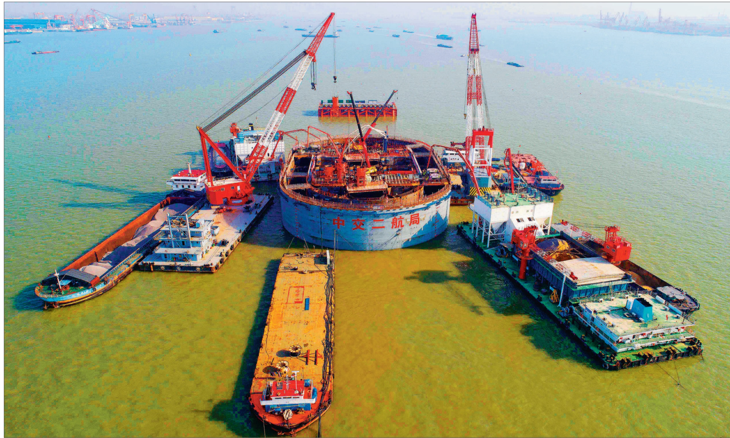
▲2月22日，位于江苏省泰州市常泰长江大桥第5号墩钢沉井建设工地，中交二航局建设者在第5号墩钢沉井内进行混凝土浇筑。常泰长江大桥是世界上首座集高铁、普通公路、高速公路“三位一体”的大桥。 顾继红摄
