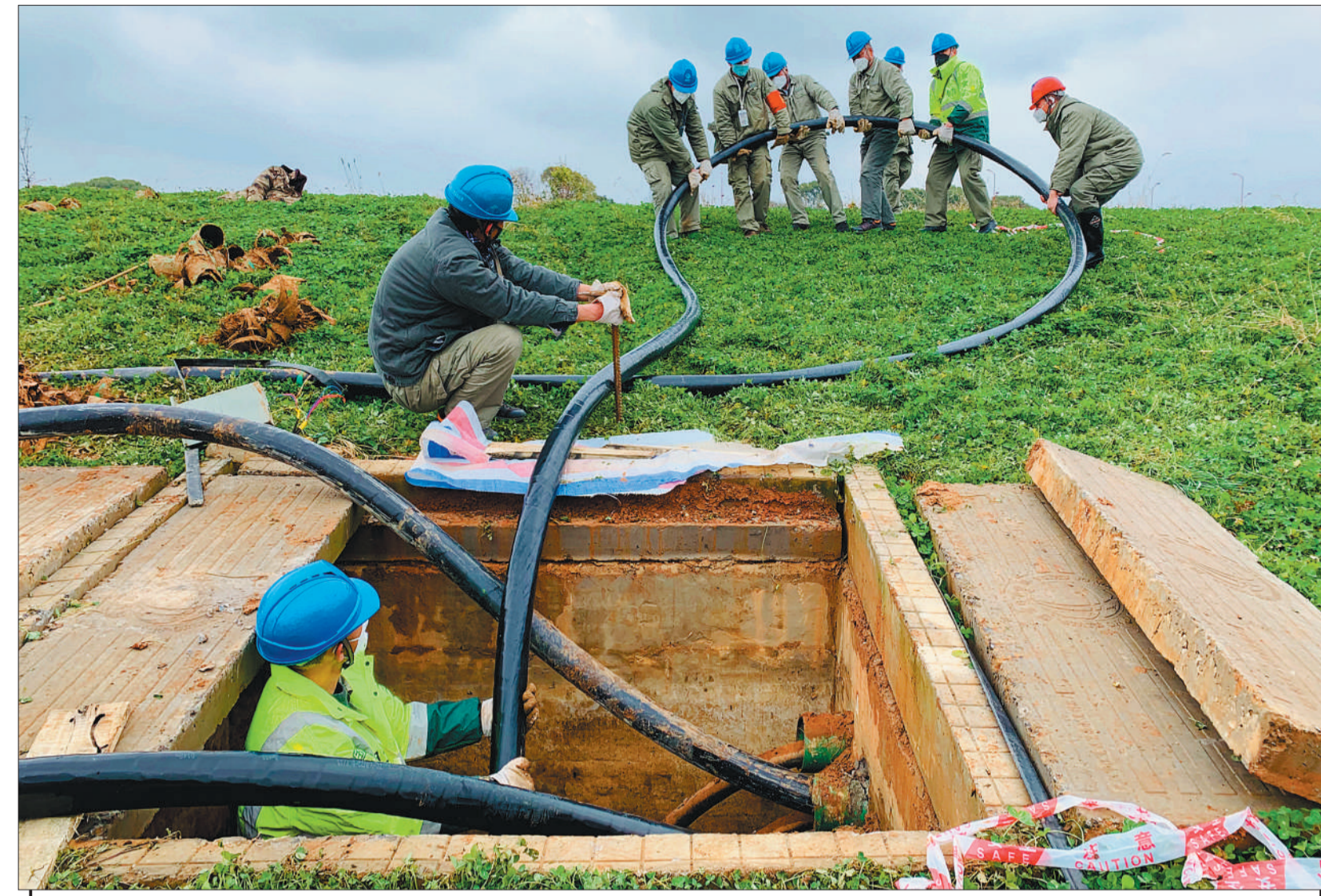
▲1月29日，国家电网武汉市江夏区供电公司电力工人在雷神山医院建设工地敷设电缆，全力以赴保障电力畅通。 左卫兵摄
