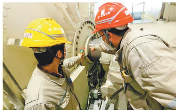
大唐五彩湾北一发电有限公司职工在测试发电机组轴瓦温度。王前喜摄(中经视觉)
