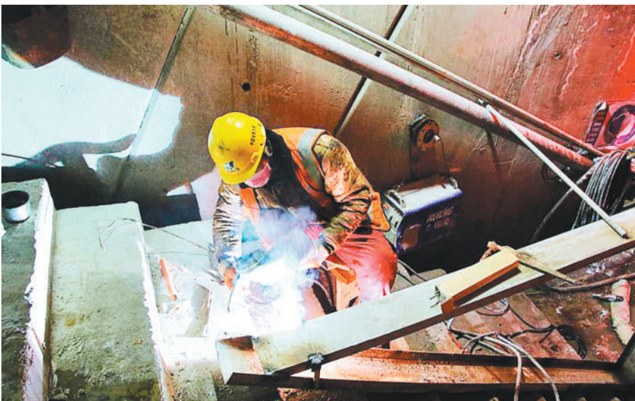
西藏最大在建电源项目部分复工,因为施工人员在现场焊接作业。
