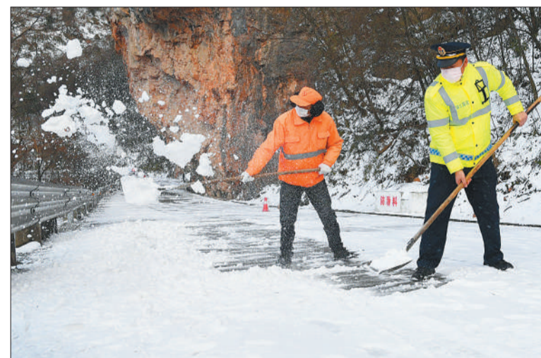
▲2月15日，在海拔1300米的241国道湖北省保康县后坪镇红岩寺路段，工作人员正铲冰除雪，全力以赴保障疫情防控应急车辆和防控物资安全畅通。 陈泉霖摄
