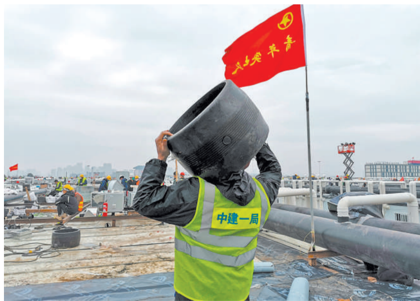
中建一局三公司青年突击队在雷神山医院项目施工中。
