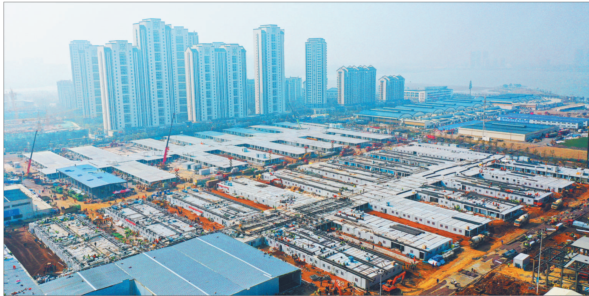
▼2月5日，湖北省武汉市雷神山医院建设现场，由廊坊天雅桥隧设备制造有限公司、河北佳节能科技有限公司、河北一木集成房屋科技有限公司等建造的箱式房，为快速建成的雷神山医院提供保障。本报记者 高兴贵摄
