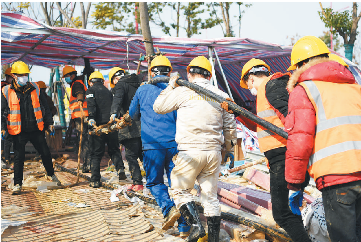
二月五日,武汉雷神山医院施工现场,建设者在紧张地安装电缆。本报记者 高兴贵摄
