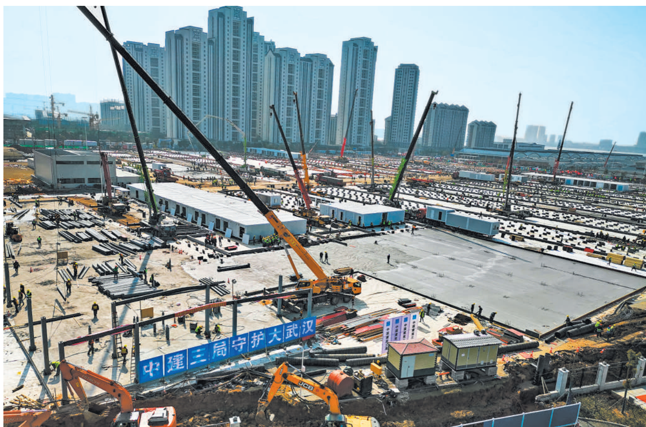
一月三十一日,武汉雷神山医院建设现场。
