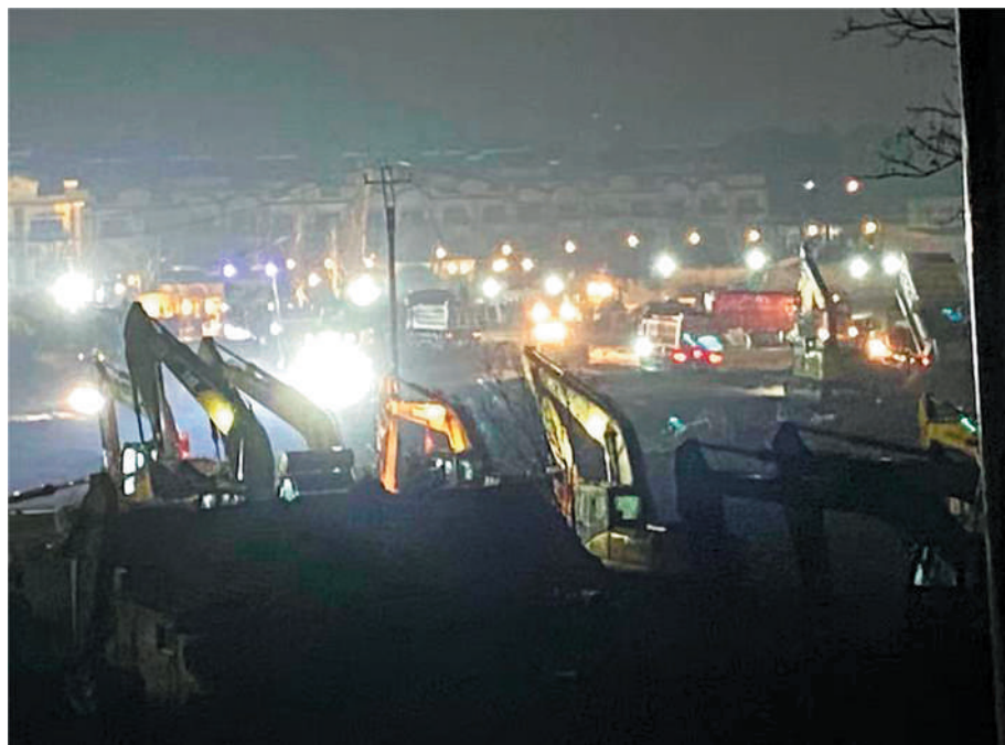
中建三局、武汉建工等企业昼夜施工，抓紧建设武汉版“小汤山医院”武汉蔡甸火神山医院。（中建集团供图）
