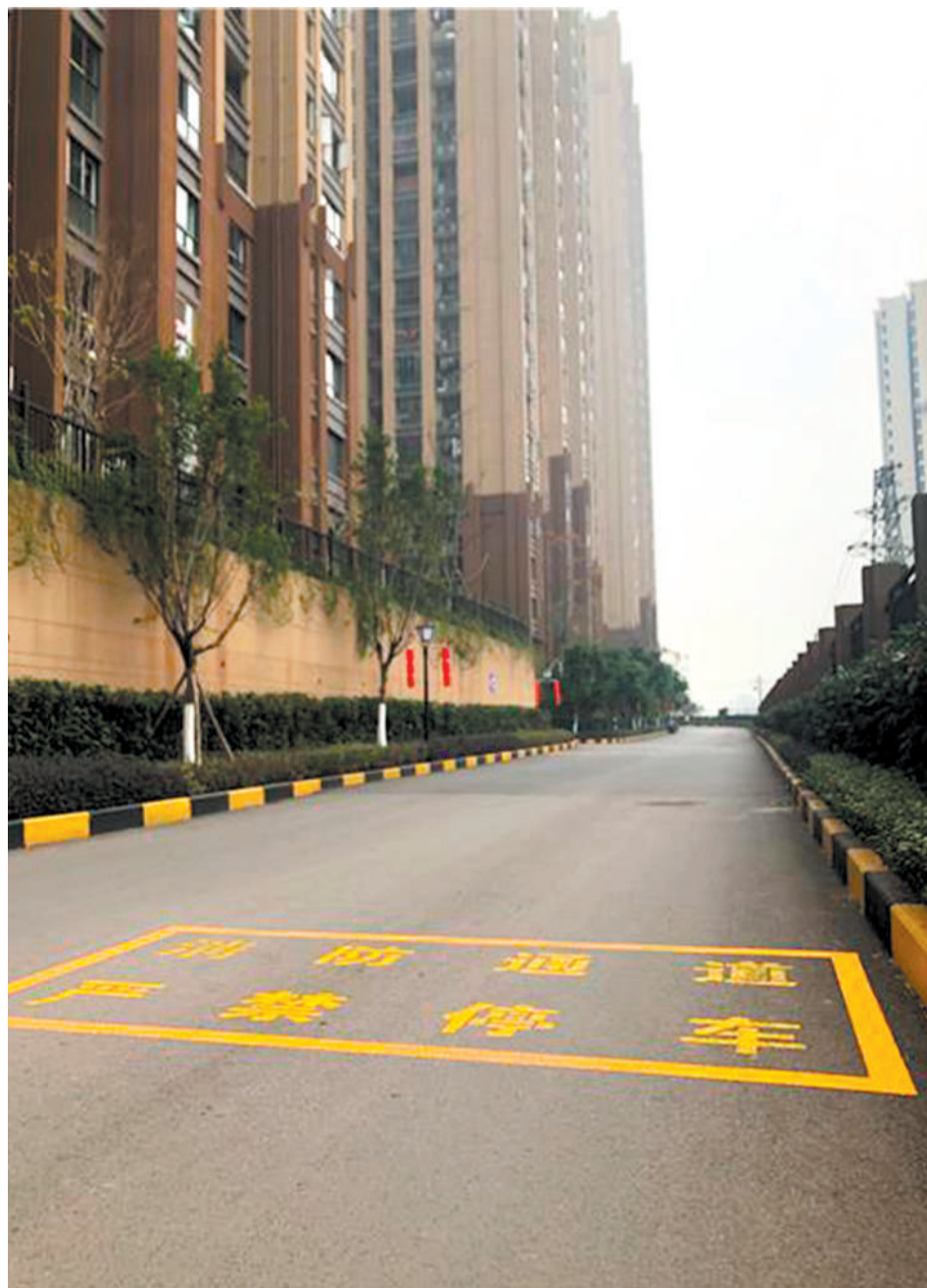
重庆某新建小区施行行人车分流，消防通道标识明确。 本报记者 常理摄
