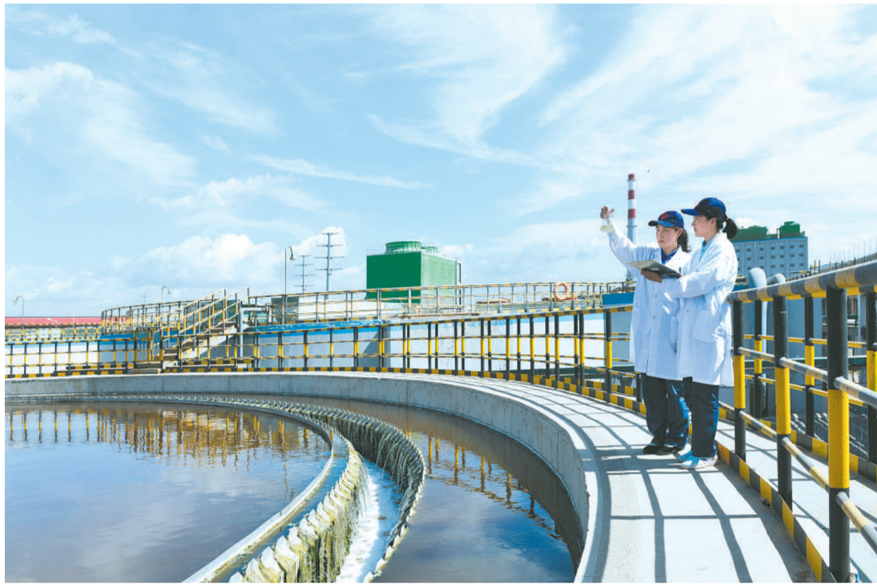
图为三友集团工作人员正在废水处理装置处采样。
