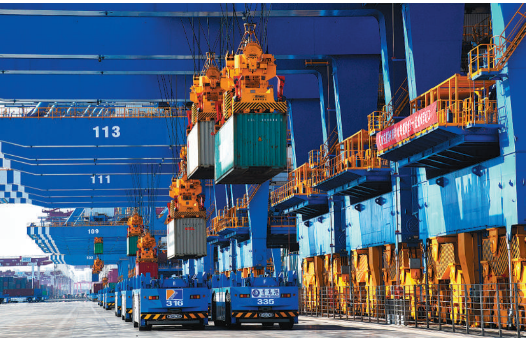
2019年11月28日，青岛港全自动化码头（二期）现场，自动导引车在等候装运集装箱。当日，山东港口青岛港全自动化码头（二期）投产运营。 新华社记者 李紫恒摄
