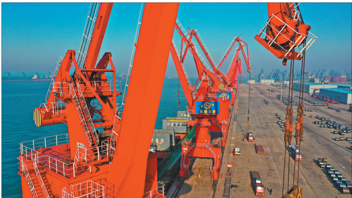
▶12月4日，首钢京唐公司成品码头繁忙的作业现场。该码头已成为北方地区最大的精品钢材专业化码头，公司生产的产品通过这里发往全国各地，被誉为“海上钢铁梦工厂”。
