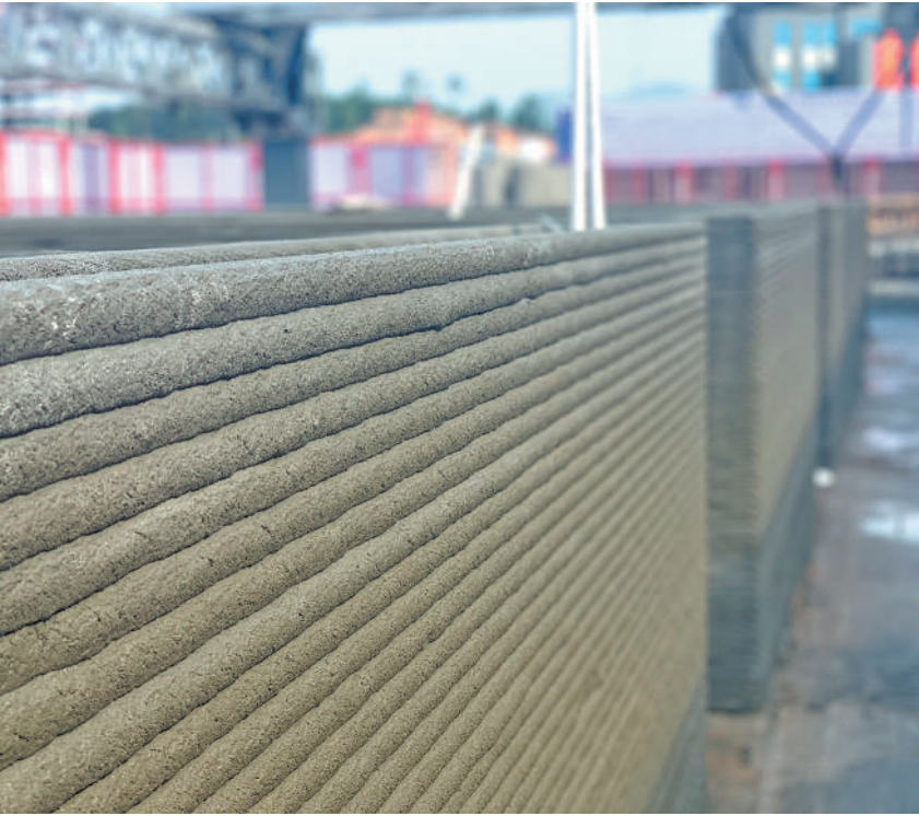
上图 施工人员在3D打印墙体施工中。
