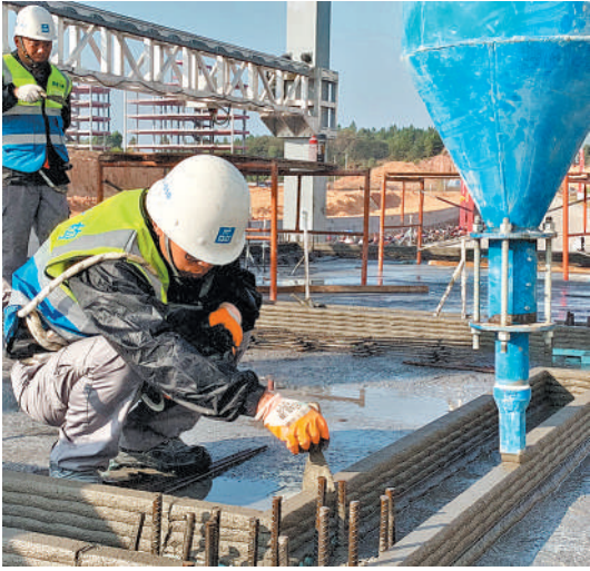
上图 施工人员在3D打印墙体施工中。
