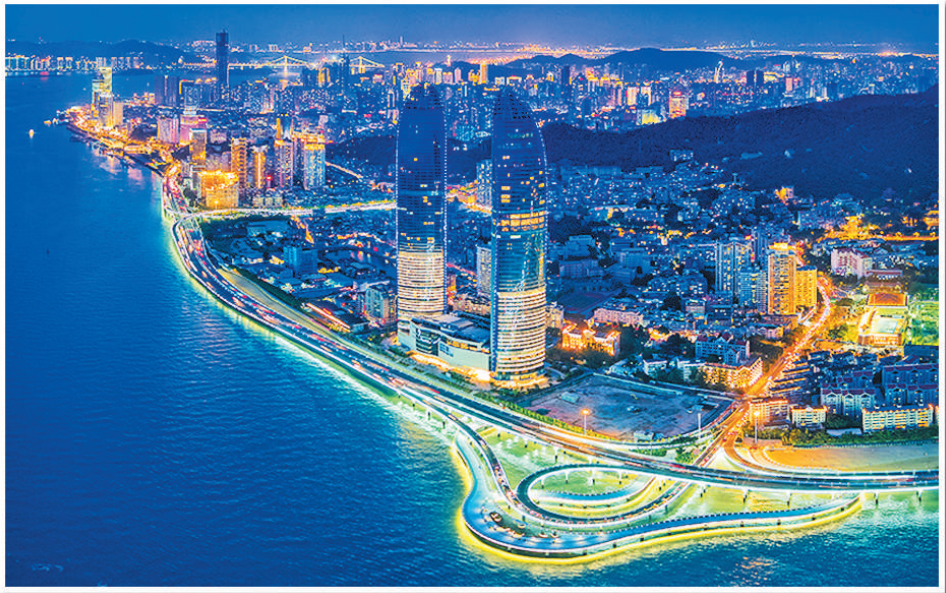
厦门演武大桥夜景。
