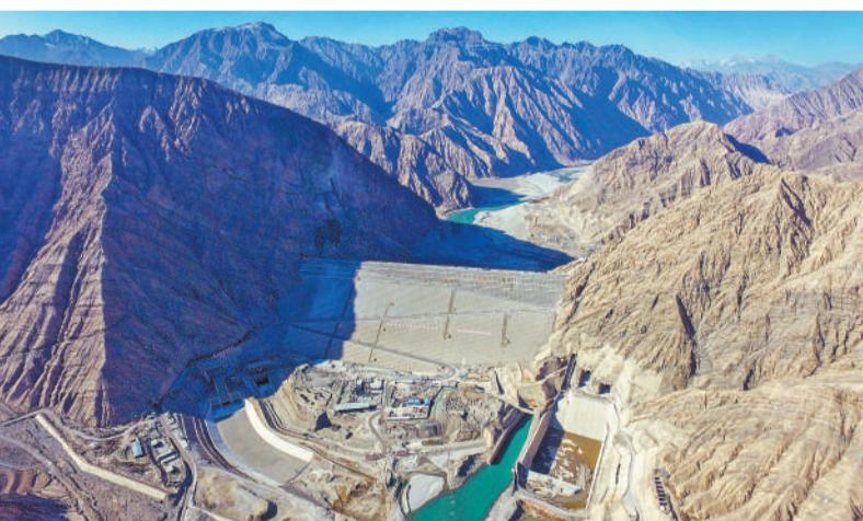
从空中俯瞰叶尔羌河阿尔塔什水利枢纽工程水库大坝(11月19日无人机拍摄)。当日,大坝下闸蓄水,将抵挡波涛汹涌的洪水,使叶尔羌河流域彻底告别千年水患。该工程位于新疆喀什地区莎车县霍拉甫乡和克孜勒苏柯尔克孜自治州阿克陶县的库斯拉甫乡交界处,是新疆目前在建的最大水利枢纽工程,总投资109.86亿元,将在保证塔里木河生态供水条件下,发挥防洪、灌溉、发电等综合利用功能。
